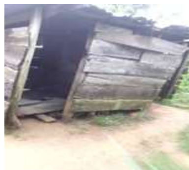
Latrines des filles
